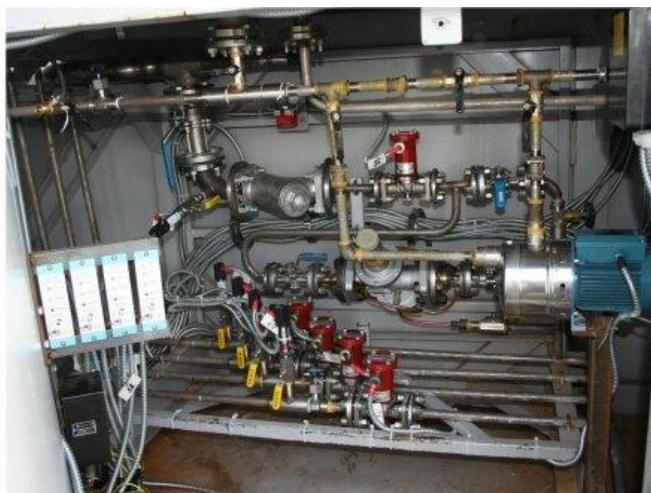
**Фото3. Узел распределения топливного газа к горелкам**
