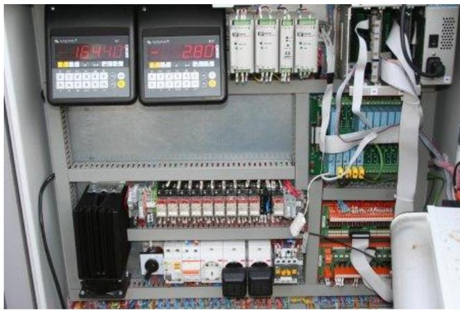
**Фото4. Блок автоматики управления рабочими процессами**
